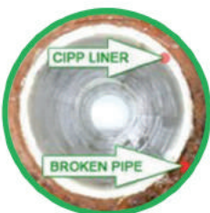
NO DIG PIPE LINING
